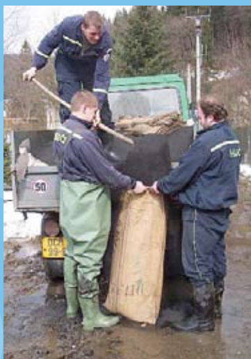
Pískem plněné pytle jsou pracné a drahé
